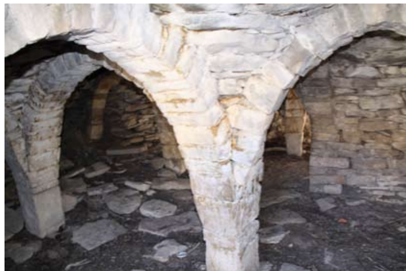
Подземные постройки в селении Хой
