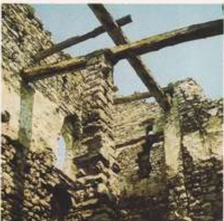
35. Селение Таргим Остатки межэтажных перекрытий жилой башни
